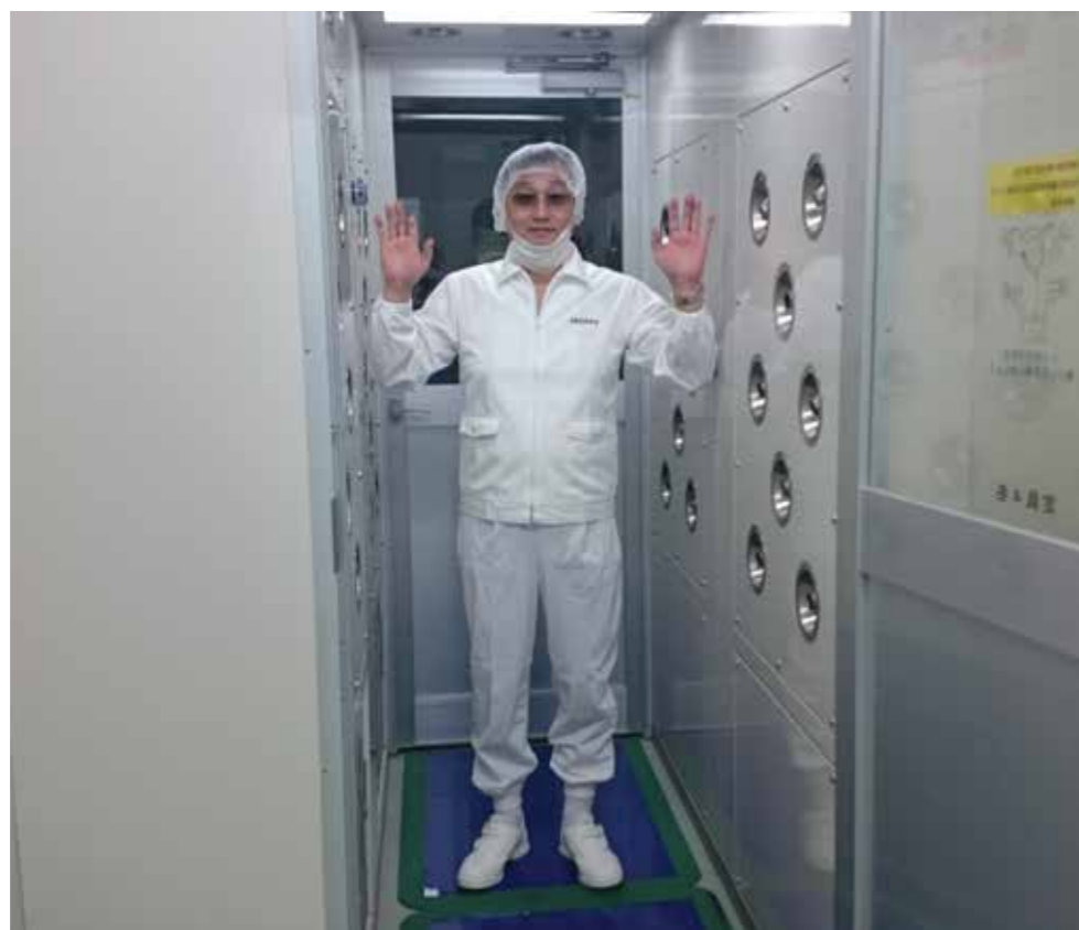
Перед входом в цех завода необходимо пройти обработку газовым душем
